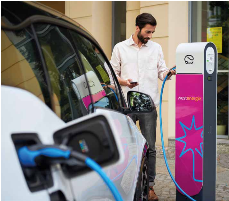
Verteilnetzbetreiber Westnetz nutzt die InGA zum Management von 1.200 Ladepunkten.
